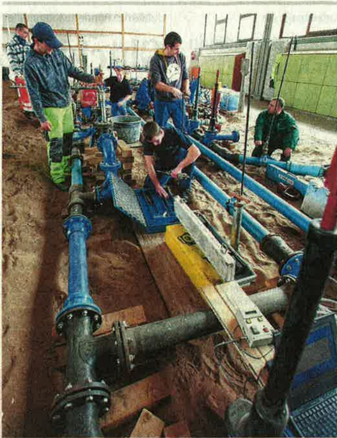
Trockenübung im Team: In zwei Tagen haben die jungen Azubis in Werkstatt 9 ein Wasserleitungssystem nach neuesten technischen Standards verlegt. BILD: RITTELMANN
